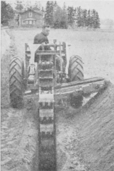
Kuva 1. Ferguson -traktoriin liitetty salaojan kaivukone työssä hietamaassa Tikkurilassa.
