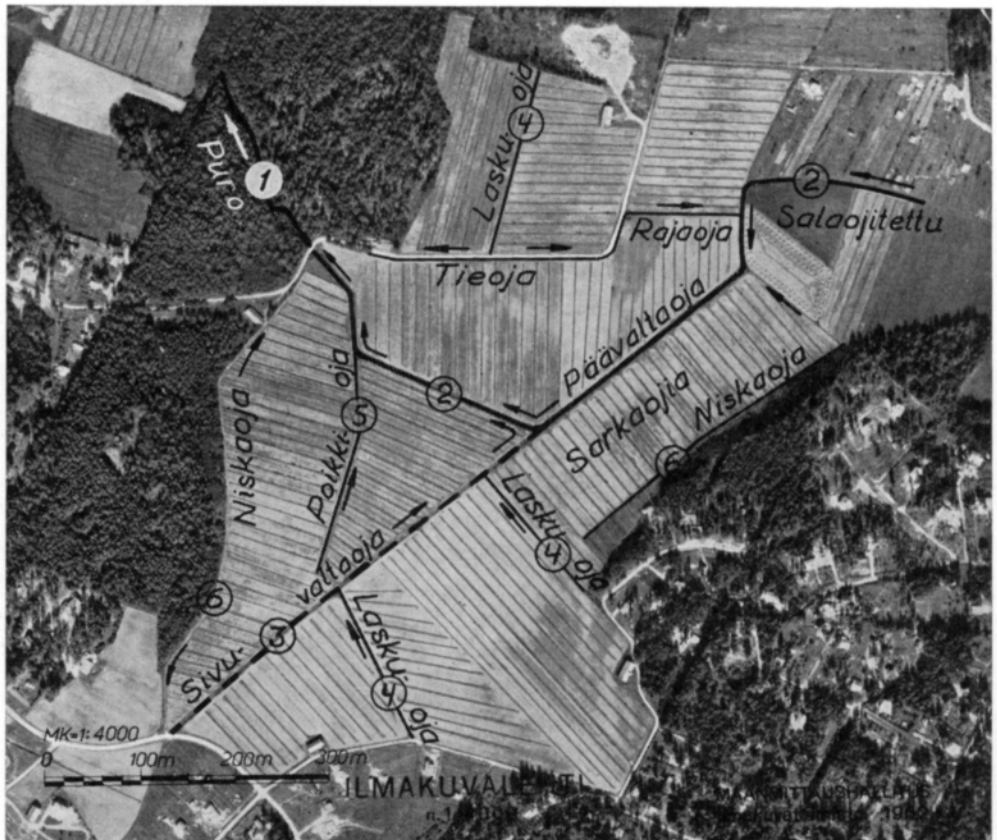
Kuva 1. Avo-ojitettu peltolohko Hämeenkylässä Uudellamaalla. Päävaltaojan (2) ja sivualtaojan (3) mitoitus on oleellisesti vaikuttanut läpikulkuviesien määrää. Laskuoja (4) ohjaa niskaajista (6) kertyneet vedet ja notkonteeseen sijoitettu poikkioja (5) sarkaojia ja maanpintaa myöten valuvat vedet edelleen valtaojiin. Peltolohkon ulkopuolella muuttuu vesiuoma vähitellen luonnon puroksi (1).
