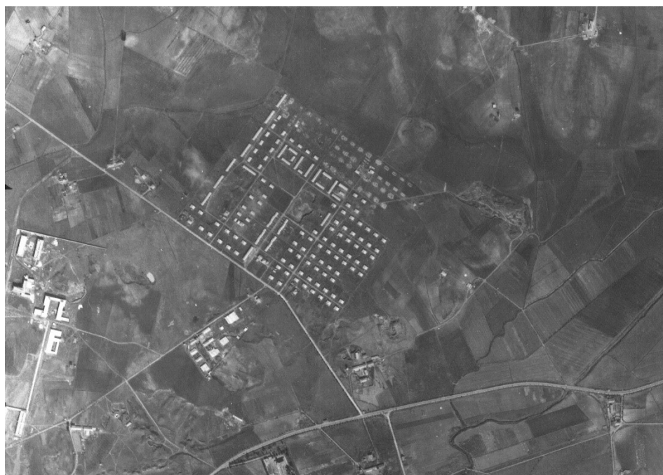
Figure 9. The borgata San Basilio near Via Tiburtina, 1944. Note the buildings forming the word DUCE . Photo: ICCD Aerofototeca (Istituto Centrale per il Catalogo e la Documentazione) in Bonomo (2006, 152).
