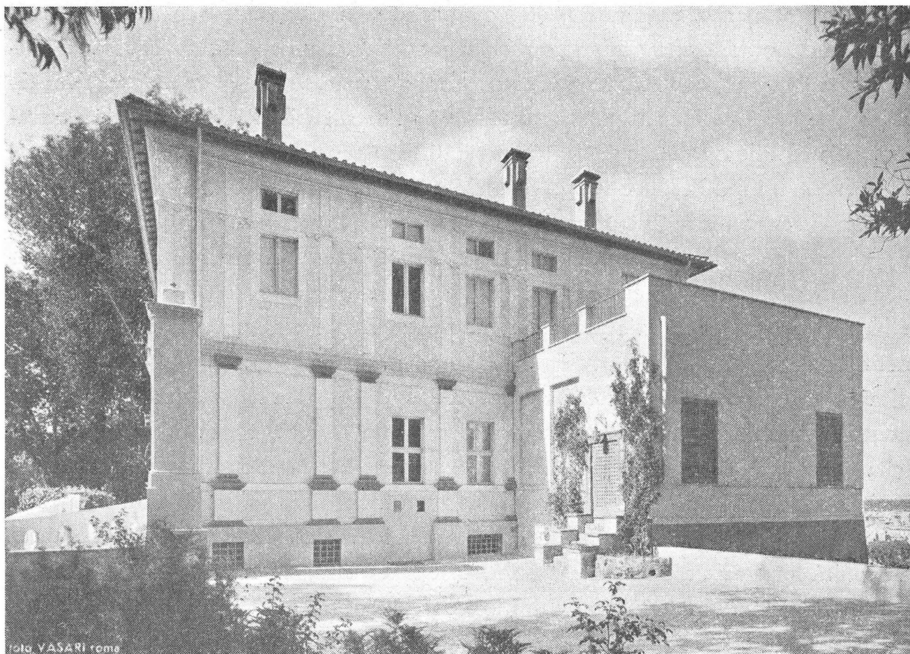
Villa Lante dopo i restauri, vista da sud.
