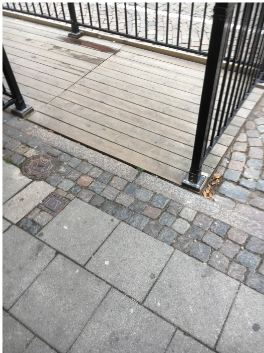
Fotografi II. För att möjliggöra för restaurangen att ha en uteservering har den offentliga trottoaren upplåtits av kommunen och här finns nu i ett inringat område ett antal bord och stolar. Istället har restaurangägaren anlagt en ramp som går ut i körfältet. Staketet och den trånga ingången till rampen har dock gjort det svårmanövrerbart för den som kommer med en större elrullstol. Foto: Kristofer Hansson.
