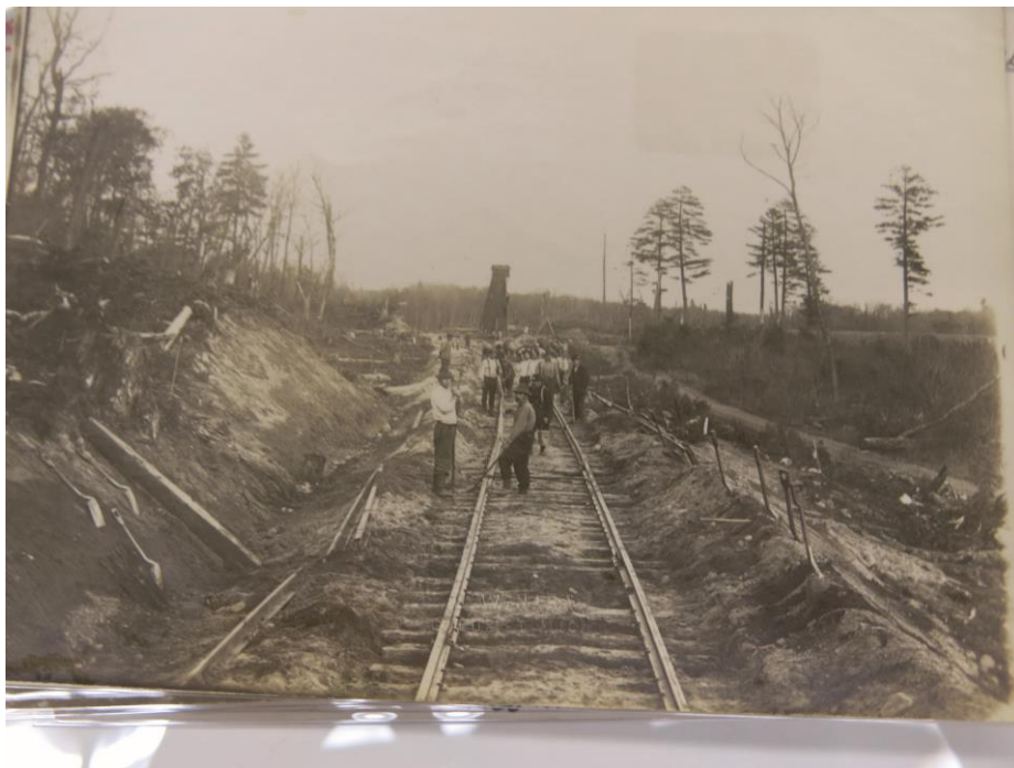
Kuva 4. Rautatien rakentamista Michiganissa. Michigan Tech Archives.
