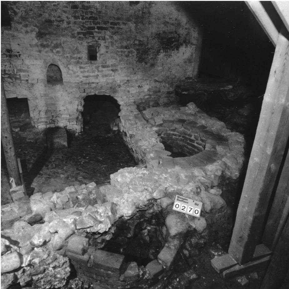
*Abb. 6. Die Brennkammern der Heizeinrichtung für den Warmwasserkessel aus der Zeit um 1500 (vorn) und vom Ende des 16. Jahrhunderts (hinten rechts) in der „Oberen Badstube“ in Wangen im Allgäu. Im Hintergrund links ist der Heizraum aus dem 17. Jahrhundert zu erkennen. Foto: Landesdenkmalamt Baden-Württemberg.*
