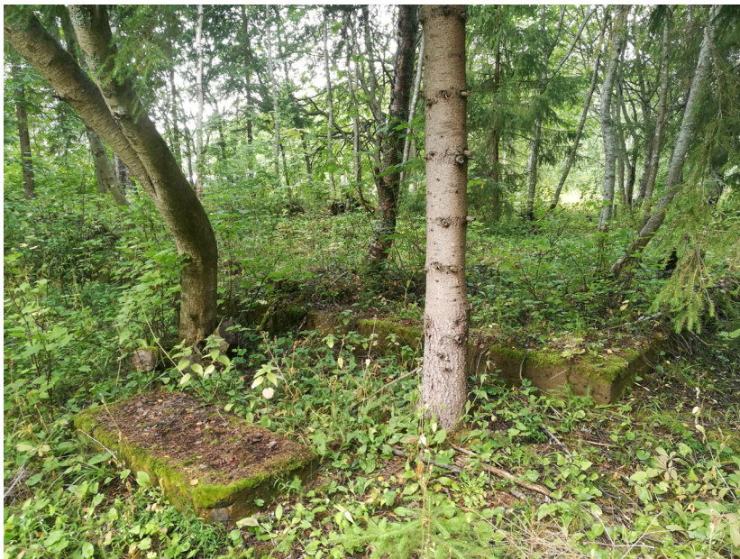
Figure 4. House ruins in 2019. (Photo: Tiina Äikäs, 2019.)
