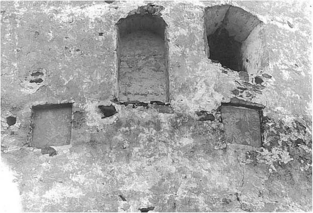
Abb. 5. Mauernische am Glockenturm zwischen den Wappentafeln Nr. 1 und 2. Foto M. Laamanen.
