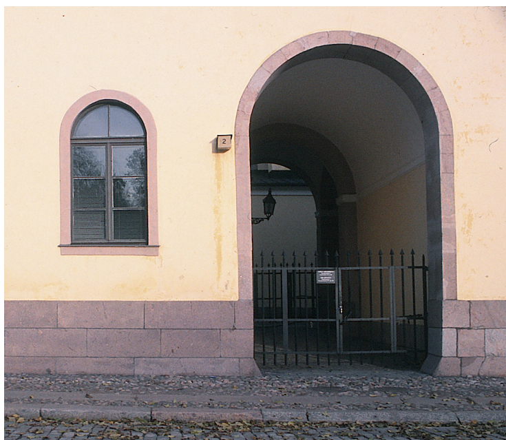
Figur 4. Sockeln på båda sidor om västra flygelns portgång. Stenarna till vänster om portgången har antagligen behandlats vid restaureringen. Färgen är jämn och ytorna hela. Till höger om portgången har sockeln tydligen inte fått en liknande behandling. Den uppvisar markanta skador, och stenarna har en ojämn färg. Foto Eeva Maija Viljo 2002.
