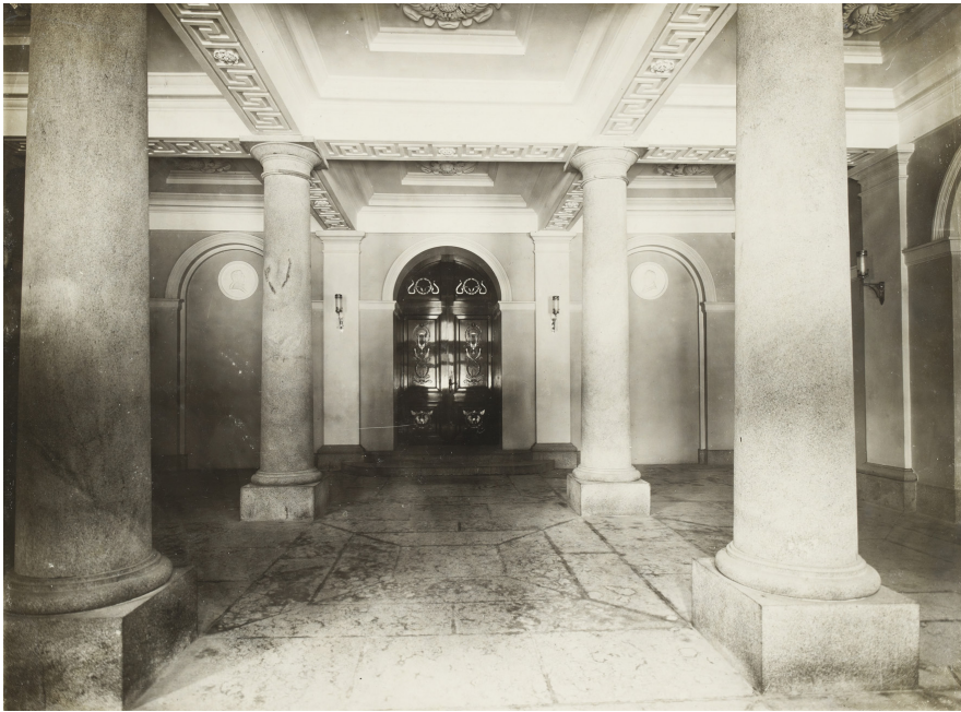
Figur 3. Stora vestibulen i Akademihusets norra flygel 1912 efter restaureringen. På kolonnerna som befriats från övermålning syns spår av reparationer. I fonden dörren till solennitetssalen, kopierad vid restaureringen efter den ursprungliga dörren, då även porträttmedaljongerna i arkadnischerna på ömse sidor om dörren sattes upp. Fotografen har sannolikt varit Alex. Nyström. Museiverket, Bildsamlingarna, Åbo Akademihus.
