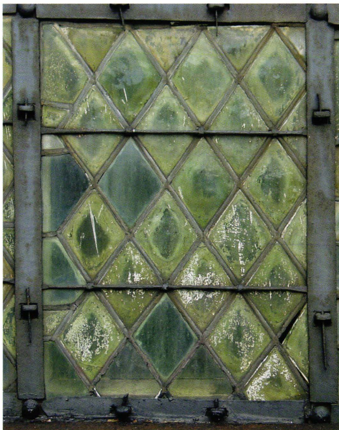
Fönstren i Askais kyrka är från år 1653. Motsvarande glasfönster – även om de var lagda i träkarmar i stället för i järnsmidda karmar – blev allt vanligare under 1600-talet. Foto: Georg Haggren.
