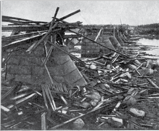
Noudattaen tuhotun maan taktiikkaa, perääntyvät saksalaiset tuhosivat rauta- ja maantiesillat. Liekon sillan jäännökset
