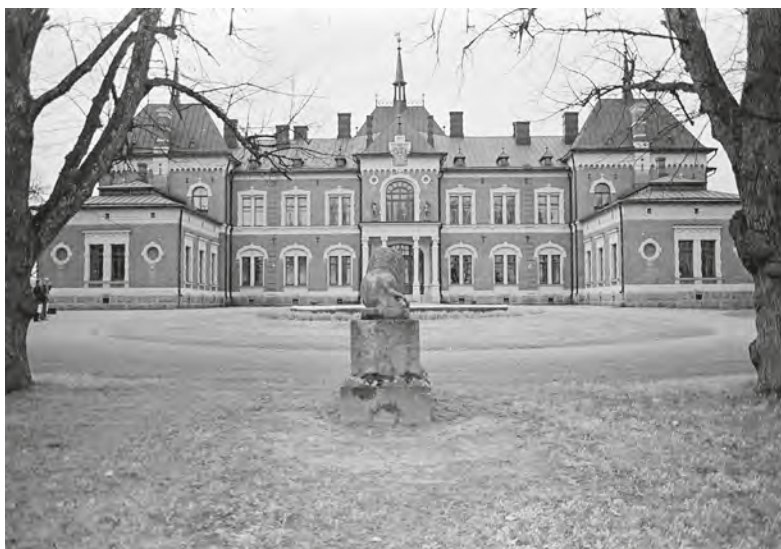
Malmgård, uppfört 1882–1888 enligt ritningar av F.A. Sjöström. Norra fasaden med huvudingången som pryddes med ätten Creutz vapen. Foto: Svenska litteratursällskapet i Finland.
