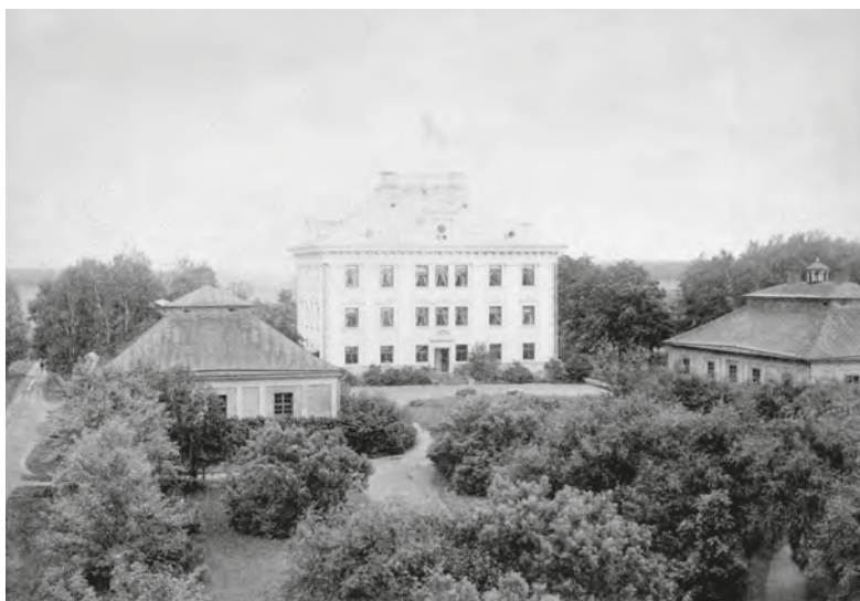
Sarvlaks fotograferat från magasinshuset 1892. På bilden syns södra fasaden och taket som de såg ut efter renoveringen 1880–1883 då man bl.a. tog bort en pilaster ovanför ingången och satte in flera fönster. Två flygelbyggnader omger gården. Den östra flygeln återuppfördes efter branden 1880. Foto: Svenska litteratursällskapet i Finland.
