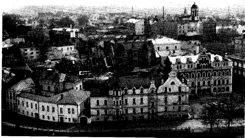
Av det medeltida Viborg återstår endast några få byggnader. De flesta av borgarhusen från 1700-talets slut har förfallit snabbt under senare år. T.ex. den gula byggnaden i förgrunden, som tillhört köpmansläkterna Borchards, Weckrooth och Perander, restaurerades på 1980-talet men de inre delarna förstördes vid en eldsvåda år 1989. Foto Jyrki Paaskoski.
