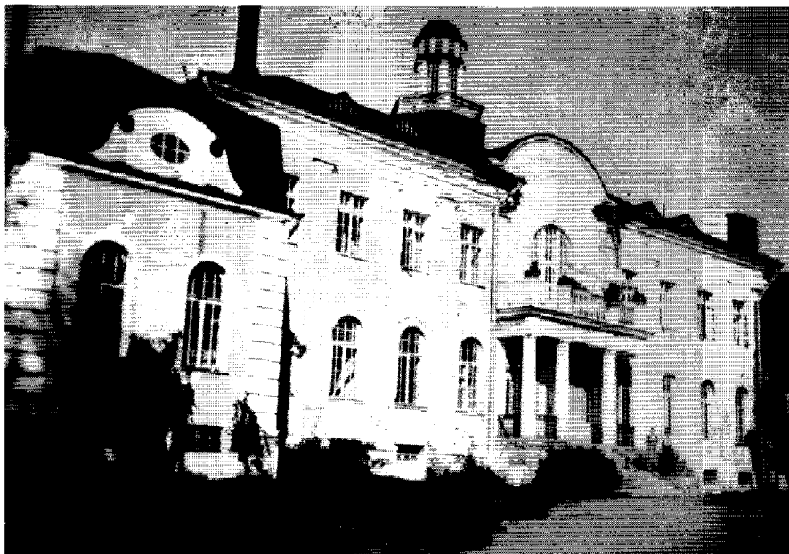
Fasaden mot landsidan. Foto från 1920-talet. (Imatra stadsmuseum).
