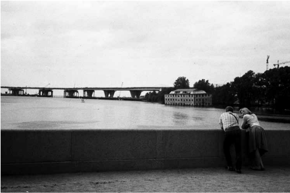
Näkymä länteen Jelagininsaaren päästä kun Pietarin ohitustietä ZSD:tä rakennettiin. Kamera: Smena 8M.
