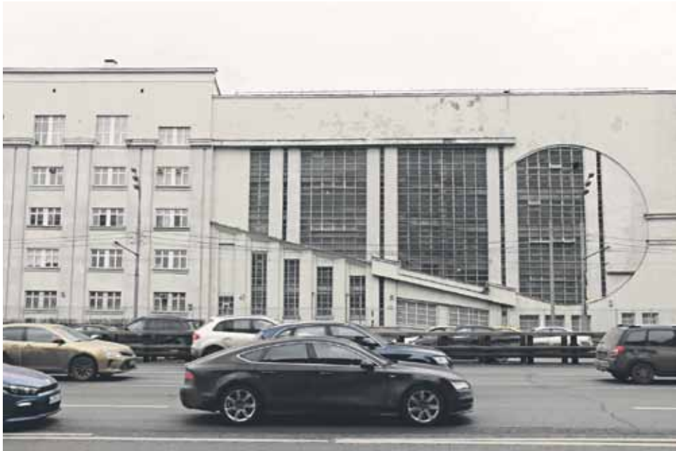
Intouristin autotalli (ulitsa Suštšovski Val 33). Lukuisia konstruktivistisia rakennuksia suunnitelleen Konstantin Melnikovin luomus toteutettiin 1930-luvulla uuden matkatoimisto Intouristin käyttöön. Suuressa rakennuksessa valoa antavan fasadin takana pidettiin Intouristin käyttämiä linja-autoja ja muita liikennevälineitä, viereisessä talossa oli toimistoja. Nykyään talli on purettu, mutta etuseinä on suojeltu ja jätetty paikalleen Moskovan Puutarhakehätien varteen.
