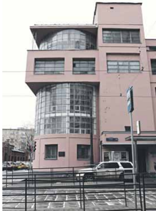
Zujevin työläisten klubi (ulitsa Lesnaja 18). Arkkitehti Ilja Golosovin (1883–1945) työläisten tapaamis- ja harraste-tilaksi 1920-luvun lopulla suunnittelema paikka. Suurehkon rakennuksen sisällä oli kirjasto- ja sanomalehtisali, harrastehuoneita ja auditorio. Päätyseinän lasirakenteita muurattiin umpeen neuvosto-aikaisten remonttien yhteydessä, mutta muuten muoto on säilynyt entisellään. Sylinterimäisessä lasiosassa kulkee portaikko. Rakennuksessa toimii nykyään teatteri.
