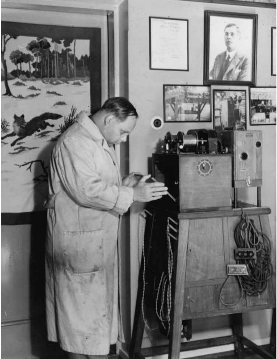
Kuva 6. Göran Tigerstedt veljensä Eric Tigerstedtin äänielokuvakoneen äärellä noin vuonna 1940. Kyseinen teräslankaa ja filminauhaa synkronoiva äänielokuvakone kuuluu nykyisellään Tekniikan museon kokoelmiin. Lähde: Tekniikan museo, Eric Tigerstedt -kokoelma.
