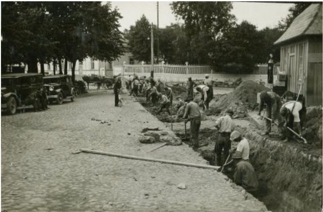
Kuramontussa. Vesijohto- ja viemäryömaa Raumalla 1930-luvulla. Rauman museo.
