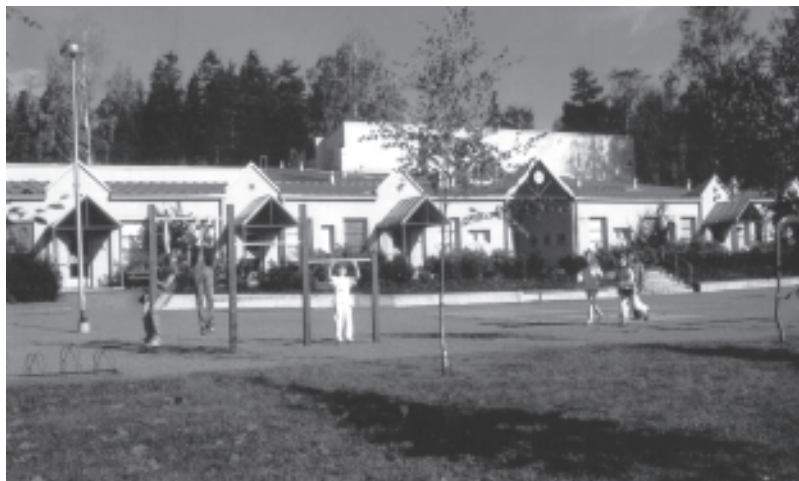
Naulakallion koulu on ajanmukainen sekä sisältä että ulkoa. Oppilaiden touhut koulun pihalla osoittavat että lukuisat pihatelineet ovat ahkerassa käytössä.
