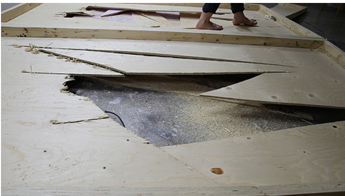
Work-in-progress. Kuvat: Matti Tanskanen.
