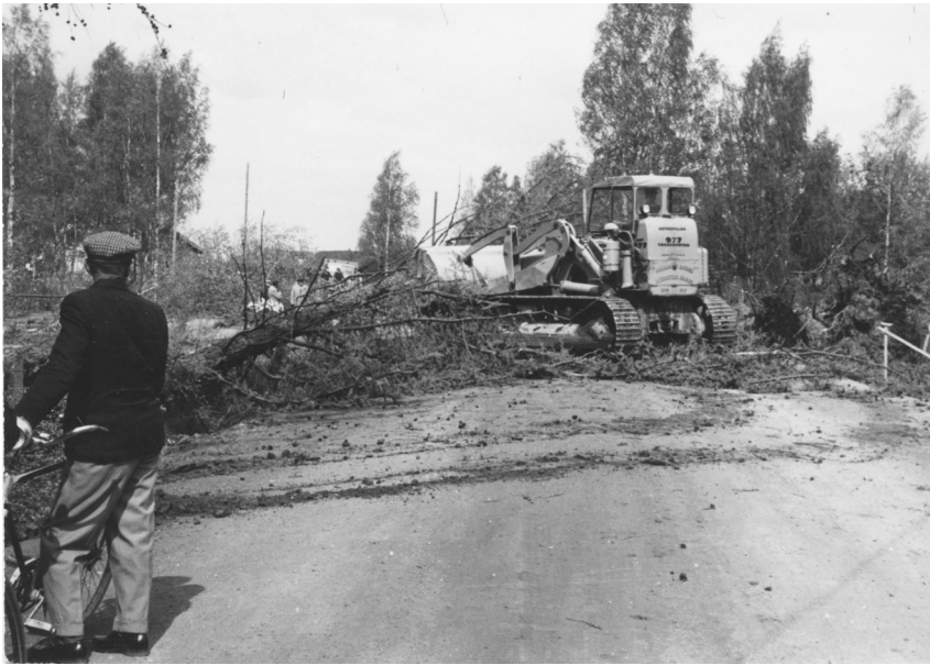
Kuva 3. Ensimmäiseksi Ilmajoelta katosivat koivukujat ja puistot. Teitä levennettiin ja puistomaisia alueita kaavoitettiin yksityiselle ja julkiselle uudisrakentamiselle. Ohikulkuteiden rakentamisella pyrittiin ohjaamaan nopea liikenne pois keskustoista. Vanhojen teiden mutkat oikaistiin turvallisuussyistä. Maansiirtokoneilla tietä syntyi paikkaan kuin paikkaan. (Ranta 1999, 33, 270.) Kuvälähde: Vesa Luoman kokoelmat.
