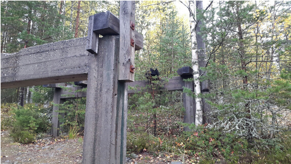
Kuva 2. Mäkitornin betonijalustat kestävät aikaa, vaikka puurakenteet ovat kadonneet. Höytiäisen mäkitornin jäänteet Lykynlammella. Kuva: Ismo Björn.
