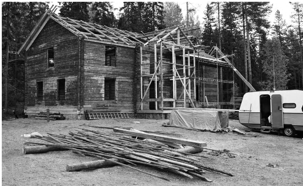
Kuva 6. Siirrettyä Haapa-ahoa rakennetaan Ähtärissä.
