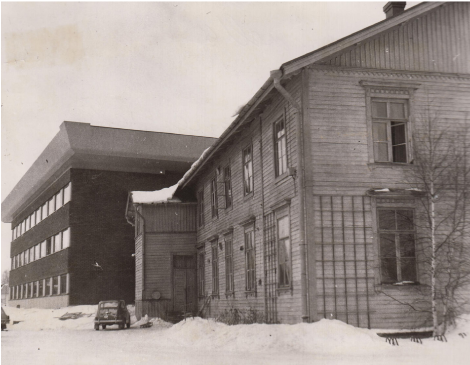
Kuva 4. Purettavaksi tuomittu vanha kunnallistalo ja uusi kunnantalo ehtivät olla vierekkäin muutamien kuukausien ajan. Keijo Petäjän piirtämä uusi kunnantalo oli edeltäjänsä vastakohta. Voimakas räystäslinja, tasakatto ja punatiilipinnat kertoivat rakennustapojen ja mieltymysten muutoksesta. Kuvälähde: Ilmajoen kunnan arkisto.
