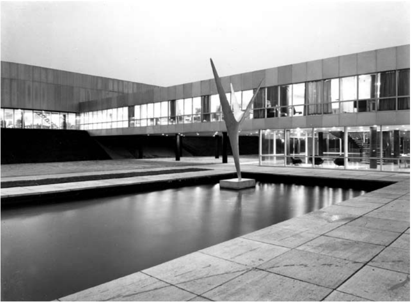
Kuva 1. Arkkitehti Viljo Revell suunnitteli Hyvonin tehtaan, joka edusti uutta tehdasarkkitehtuuria Suomessa. Julkisivumateriaaleina käytettiin lasia, poimutettua alumiinia ja betonia ja tehtaan edessä on viiden metrin korkuinen Arvi Tynyksen alumiiniveistos Valoa kohti . Tehdassalista avautuivat suuret ikkunat ympäröivään luontoon ja konttori oli ns. maisemakonttori. Valokuva Heikki Havas, Suomen rakennustaiteen museo, postikortti.
