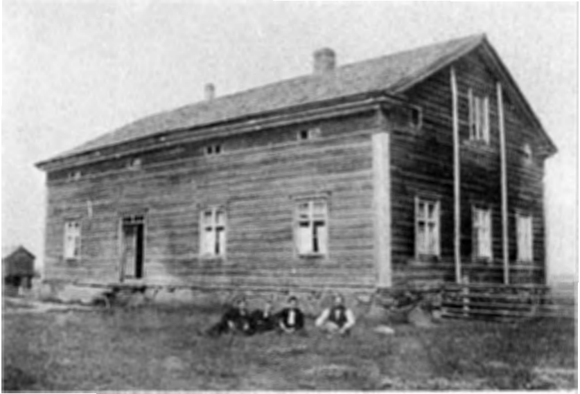
Kuva 1. Kaustisen Nikulan Seksmanin komea, tyypiltään normaali kaksitupainen sivukamaritupa rakennettiin vuonna 1792 ja purettiin 1930-luvulla. Päädyn ikkunat oli sijoitettu symmetrisesti ja räystääslistoitus oli monipolvinen ja kaunis, tyypillinen keskipohjalainen. Valokuvan omistaa Kyösti Nikula.
