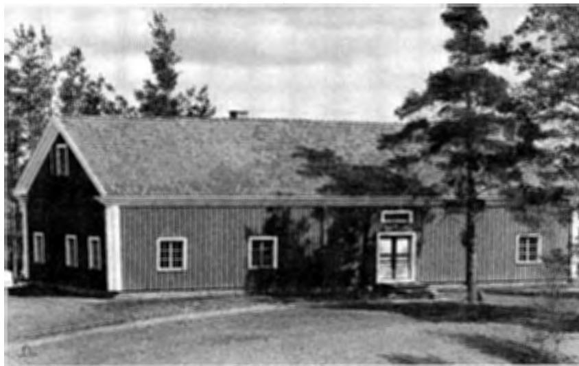
Kuvat 6 ja 7. Vetelin Pulkkisesta Kaustiselle Pelimannitaloksi siirretty Aapantupa on suurimpia sivukamaritupia. Luultavasti vuonna 1800 rakennettu talo on pohjakaavaltaan kaksitupainen välikamarillinen. Piirros V. Salmén, Kyrönmaa IX s. 46. Valokuva Leo Torppa, Kansanmusiikki-instituutin arkisto.
