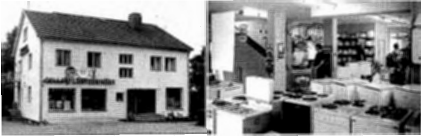
SähköLähteenmäki Oy:n konttori- ja myymälärakennus sekä myymälä sisältä. Kuvat: Paimion Sähkömuseo
