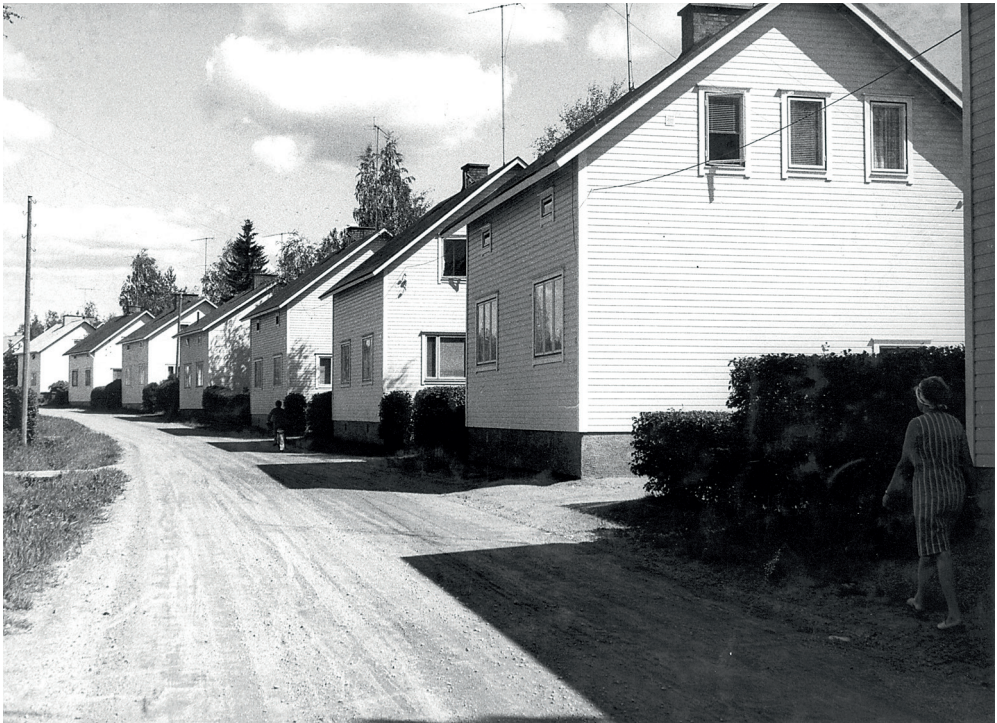
Kuva 1. Jälleenrakennuskauden pientalokulttuuri esitetään yleensä tiiviisti asuntotontteille rakennettuna näkymänä. (Pieksämäen Kontiopiisto, kuvaaja Olli Lehtovuori. Suomen rakennustaiteen museon kuvakokoelma.)
