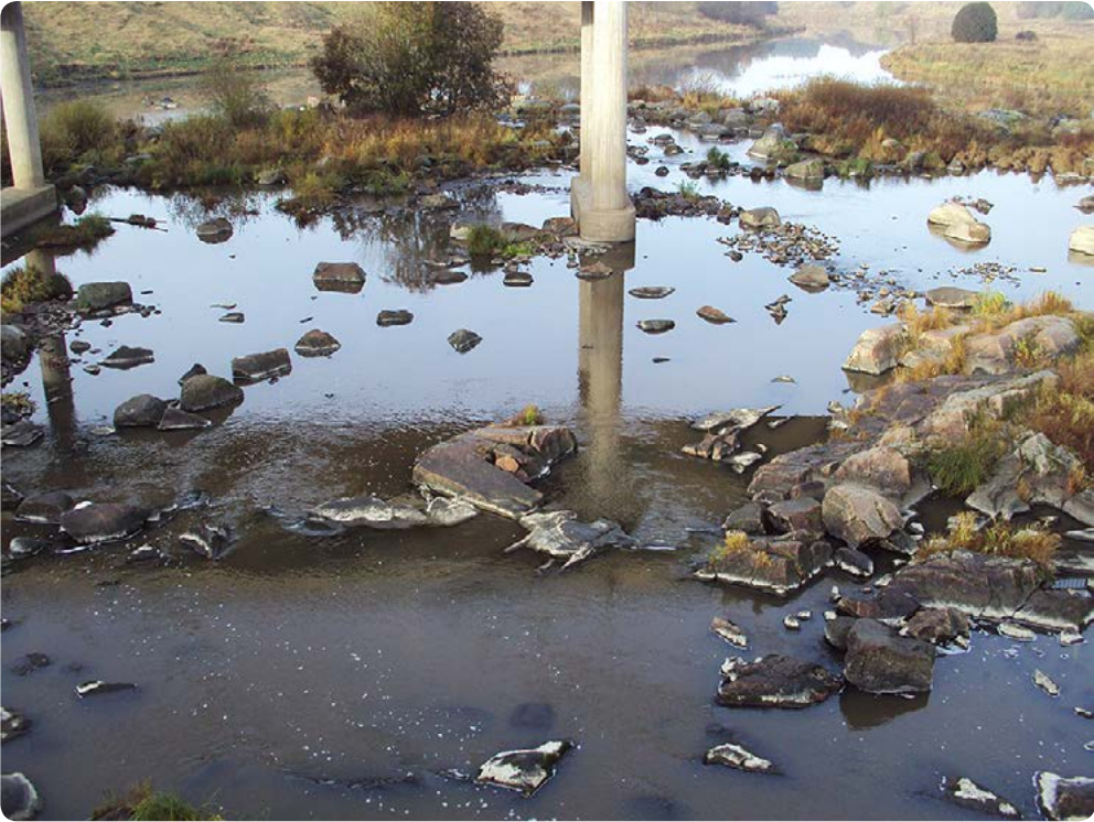
Halistenkosken virtausta on parannettu kalannousulle sopivaksi muokkaamalla virtauomaa kaivinkoneen avulla. Kuva Veli Pekka Toropainen.
