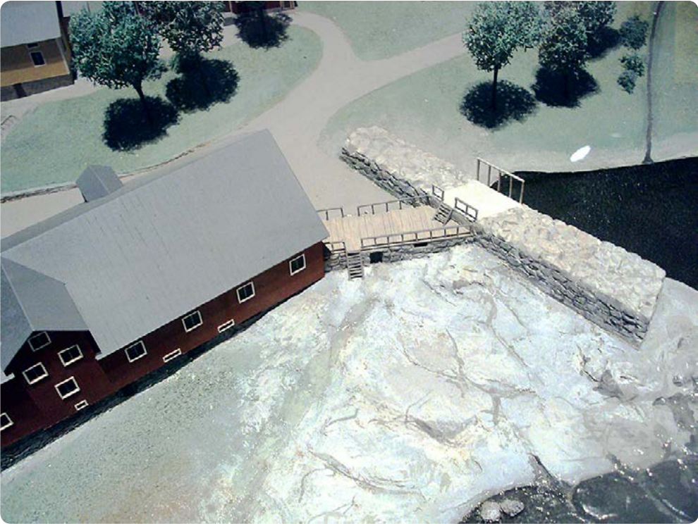
Maarian Isomyllyn kivinen suojapato ja vesikanaali, joka johti veden myllylaitokseen. Turun vesilaitosmuseo, Halistenkosken pienoismalli.
