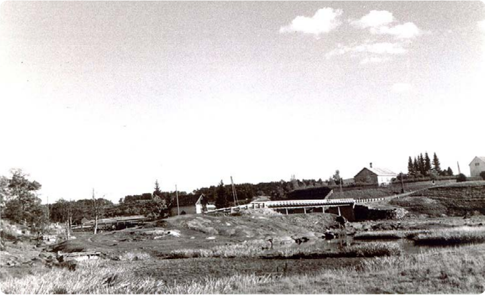
Kosken teollinen toiminta on loppunut ja suurin osa rakennuksista purettu 1960-luvulle tultaessa.
