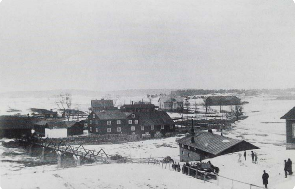
1920-luvun kuvassa näkyvät sillan takana vaalea kuivurirakennus (20) ja Maarian isomylly (15). Niiden takana pilkottavat talousrakennukset ja keskellä myllärintupa (9). Etualalla on vuonna 1908 entisen luujauhomyllyn (32) paikalle rakennettu uusi luumylly. Liukas mäki on koitunut Maarian VPK:n kohtaloksi ja työntöapua kaivataan. Kalervo Mauramon kuvakokoelma.
