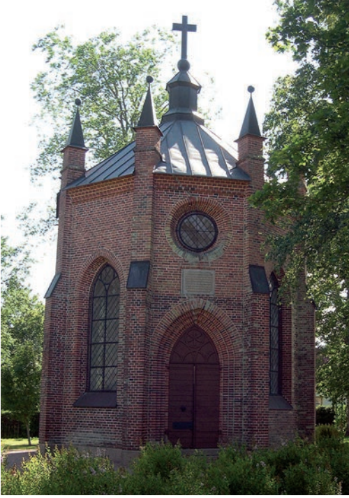
Kuva 4. Kappeli oli selvästi kallistunut joelle päin vuonna 2009. Kuva: Niina Uusi-Seppä.
