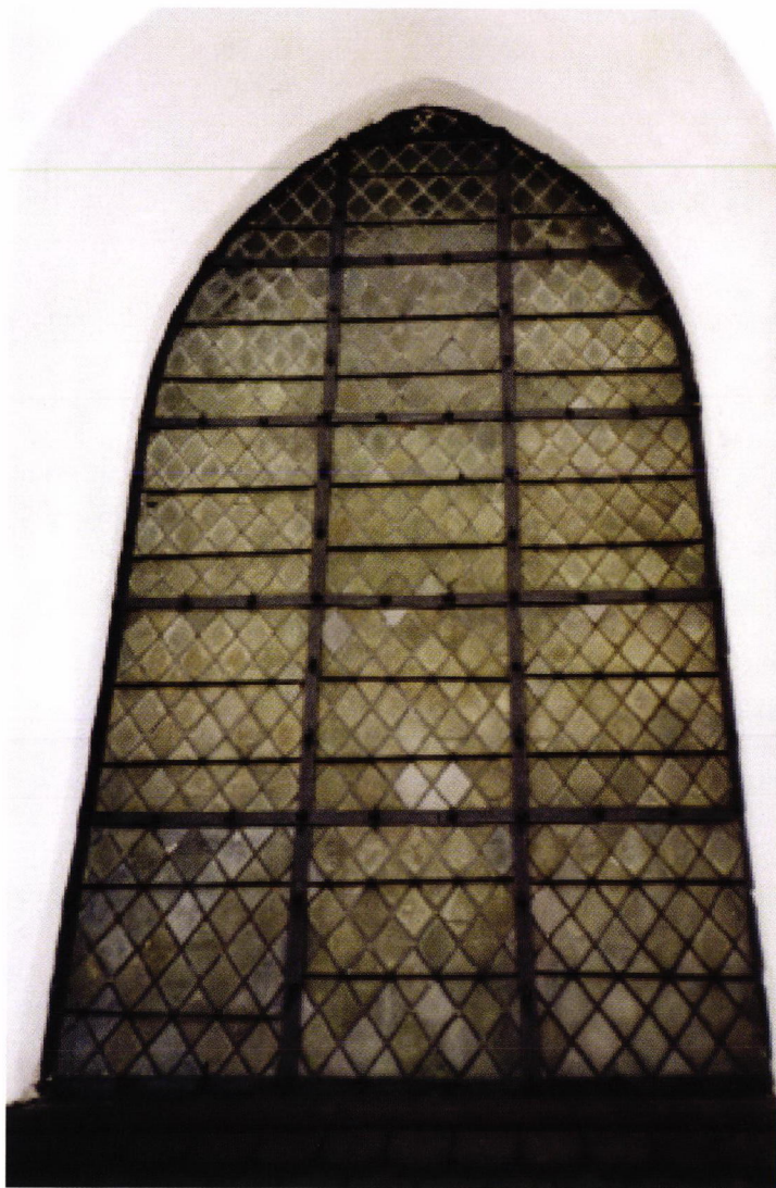
Kuva 13. Kuori-ikkuna, jossa erottuvat selvästi sekä kapeat tuuliraudat että ikkunoita sitovat raskaat rautarakenteet. Kuva G. Haggrén 2004
