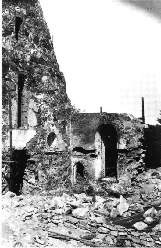
Kuva 2. Kirkon luoteisnurkka palon ja sivusakaroiden purkamisen jälkeen. Itäpäädyssä näkyy keskiaikaisen pyöröikkunan aukko ja nurkassa ulkoisen saarnatuolin aukkoon vienyt muurin sisäisen käytävän suu. Sääksmäen kirkon arkisto.
