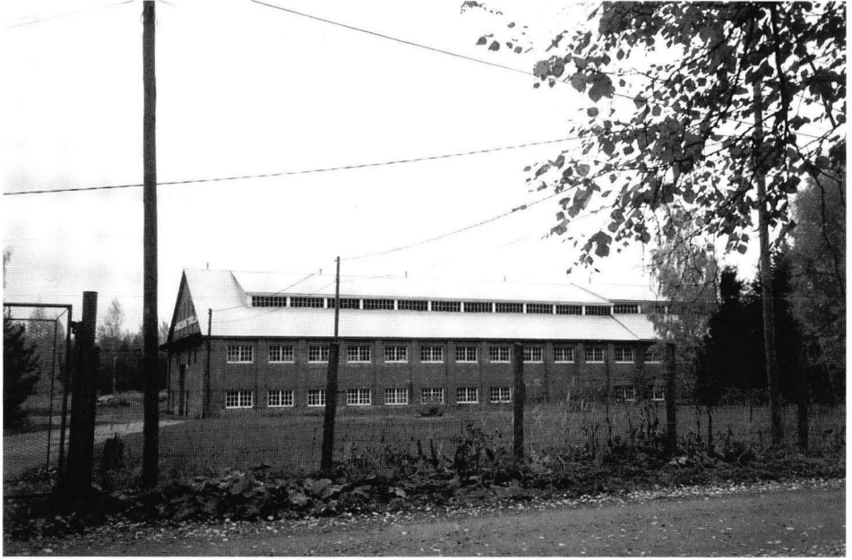
Kuva 1. Oy Sörnäs Ab rakensi 1930-luvulla laatikkotehtaan Tuusulan Jokelaan. Sen suljetulla, autiolla teollisuusalueella sijaitsevien entisten tehdashallien kohtalo on avoin. Valok. S. K. Spoof 1995.
