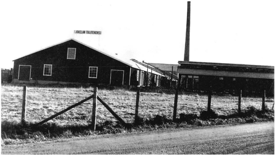
Kuva 2. Jokelan Tiilitehtaan tuotantolaitokset muodostivat 1950-luvulla lähes 200 metriä pitkän rakennusrivin. Rautatien puoleisessa päädyssä sijaitsi kuivatun, polttamista odottavan tiilen välivarasto (kuvassa). Se purettiin 1990-luvun puolivälissä uuden tielinjauksen alta. Nykyään tiilitehtaan »julkisivuna» näyttäytyy ohikulkijoille puretun varaston ja uuninsuojarakennuksen välissä ollut väliseinä. Rakennukset toimivat Tuusulan kunnan varikkona. Valok. Nikolai Breneff n. 1955. Museovirasto.
