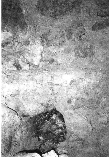
Kuva 15. Keskiaikaisen puusiteen jättämä ontelo kerroksessa I.
