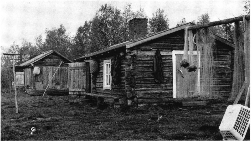
Kuva 3. Keimiöniemen Kenttärannan kaksi kämppää. Vasemmassa laidassa on vanhanmallinen puukoukuilla varustettu verkkojenkuivausteline, oikealla nauloilla varustettu nuorempi ratkaisu. – Valok. Alfred Kolehmainen 1967. Museovirasto KYKA 3799:110.
