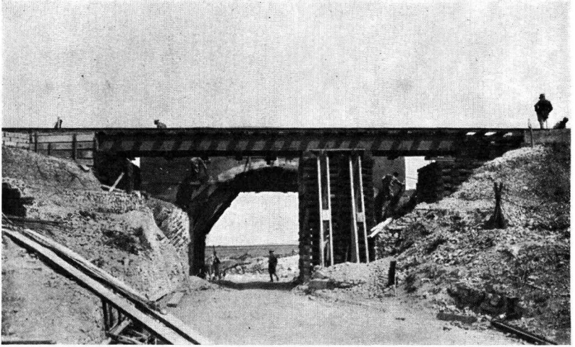
Hävitetyn rautatieylikäytävän (rata Arras—Albert) korjaus. Huom! Tukien hävittäminen on huomattavasti lisännyt korjaustöiden laajuutta.
