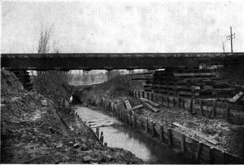
Hävitetyn rautatierummun (rata Amiens—Laon) korjaus. Huom! Hävityksen perusteellisuus on aiheuttanut sillan rakentamisen.
