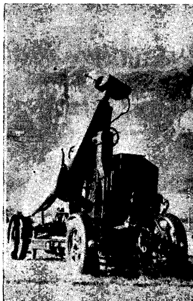
Kuva 9. Oerlikon-raketin sädeohjauslaitteen maa-asema. Alhaalla ohjauksäteiden heijastava peili ja ylhäällä maalla seuraavan pienen tutkan antenni.
