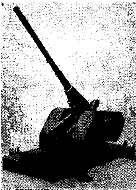
Ruotsalainen 120 mm:n liikuva it-tykki. Tulinopeus 75 ls/min. Lähtönopeus 800 m/s. Paino n 23 tn
