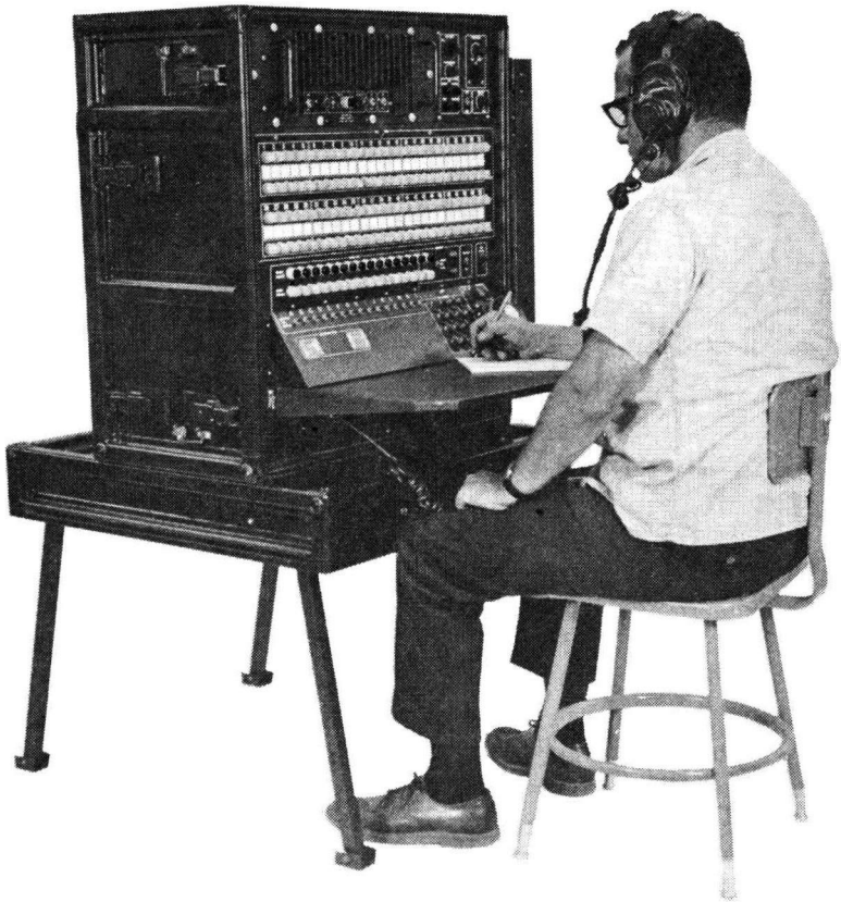
Nykyaikainen puoliautomaattinen nauhaton 50-johdon kenttäkeskus
