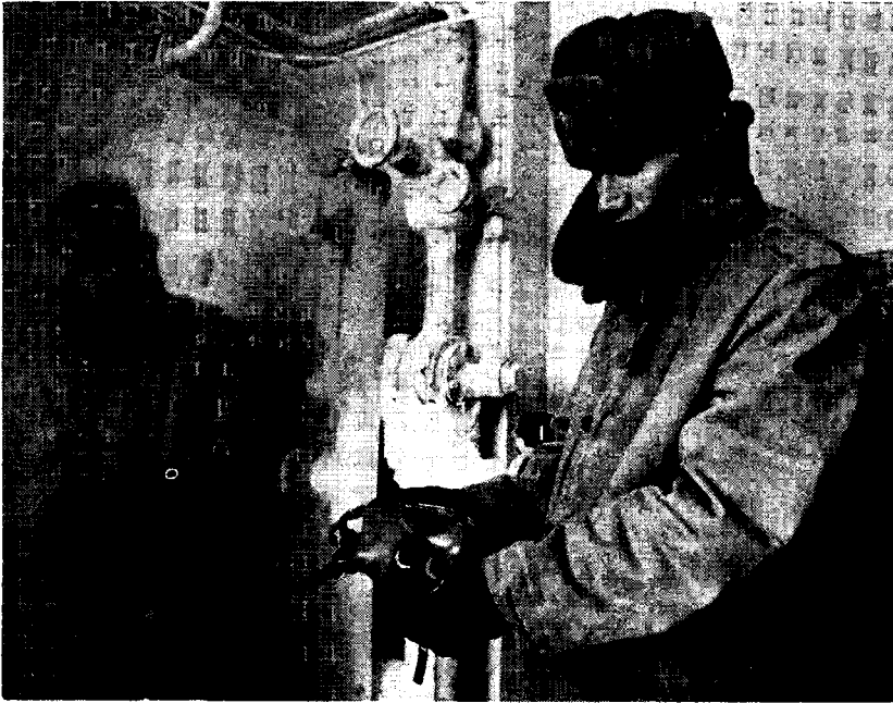
Kuva 9: Suojanaamarin kasvo-osan pakkaskoe.
