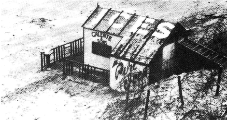
Kuva 4. Naamioitu rannikopuolustuksen bunkkeri /11, s. 114/.
