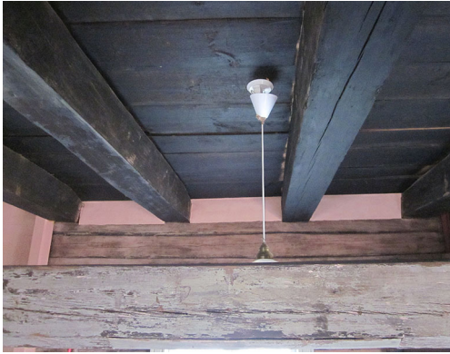
Kuva 6. Latva-Talvitien tuvan katonniskoja. Tuvan keskimmainen katonniska (vas.) on lattiasta 1,5 cm päädyn katonniskaa (oik.) alempana. Vastapäisellä seinällä ero on 1,2 cm. Kuva Matti Mäkelä. MMK.
