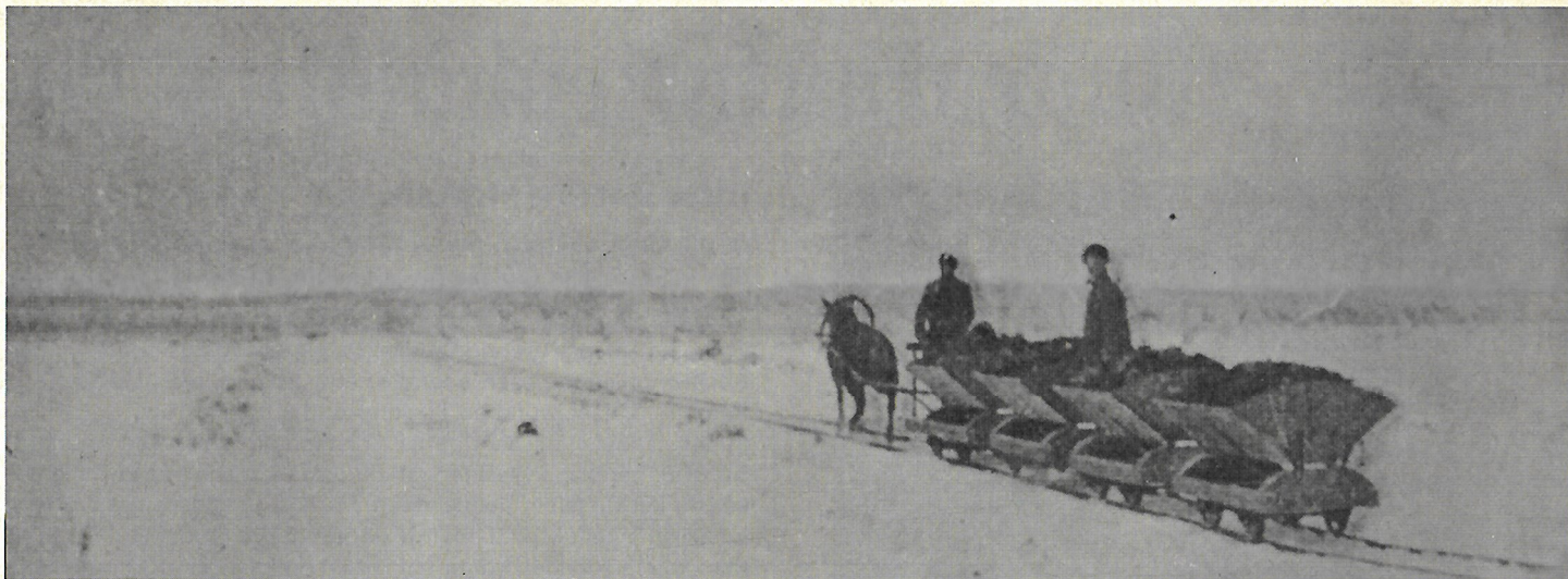
Soiden maanparannustöihin käytettiin runsaasti savea, jota kuljetettiin Leteensuolla hevosvetoisella kenttäradalla.
