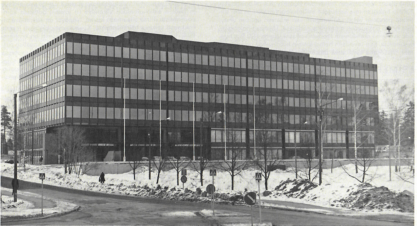
IBM:n toimitalo Tietotie 2:ssa Munkkiniemessä Helsingissä. Rakennuksen pääsuunnittelijana oli Arkkitehtitoimisto Osmo Lappo.
