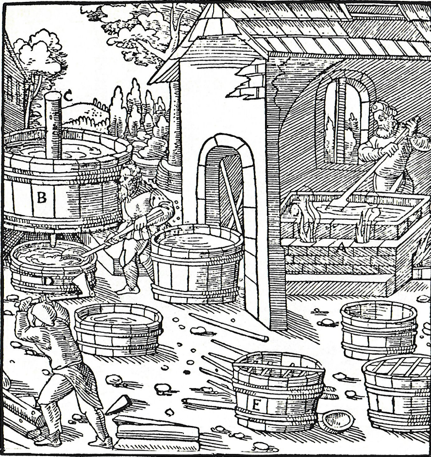
Kuva 2. Piirros salpietarinkeittimöstä. (Georgius Agricola: De re Metallica, 1556). Salpietarimaan ja tuhkan seosta uutetaan kuumalla vedellä puisessa tiinussa B, jolloin salpietari liukenee. Poistamalla tappi C salpietariliuos siivöityy tiinun pohjalla olevan olkkikerroksen läpi saaviin D, josta salpietariliuos siirretään varastotiinuihin. Kuparikattilassa A salpietariliuos väkevöidään haihuttamalla. Keiton aikana pinnalle kertyvä vaahto ja kuona kuoritaan pois. Samoin erotetaan liuoksesta ensiksi kiteytyvä ruokasuola. Riittävän väkevä kuuma salpietariliuos viedään lopulta saaviin E, jossa salpietari kiteytyy vähitellen liuoksen jäähtyessä. Kiteytymistä edistävät saaviin sijoitetut rautatangot, joihin salpietarikiteet tarttuvat. Näin saatu salpietari on vielä puhdistettava esim. kiteyttämällä se uudelleen kuumasta vedestä.
