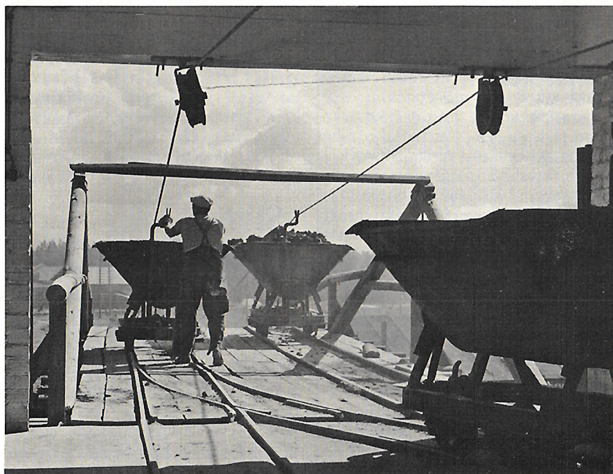
1. Savensiirtoa tehtaalle kuoppavaunulla. Kuva: A. Salonen 2. Alkupolttoa Hoffmanin rengasuunissa. Foto Roos. 3. Hoffmanin rengasuuni tulitusaukkoineen. Keskellä säätöluukkujen tankoja. Foto Roos.
