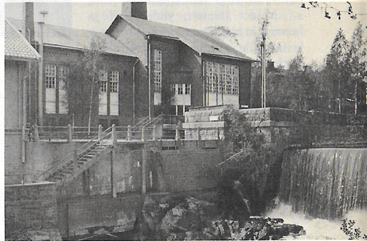
Yläkuvassa uuden perusnäyttelyn vuoriteollisuusosasto. Valok. Raimo Paappa. Alakuvassa länsirannalla oleva höyryvoima-asema ja voimalaitospato. Putouksen korkeus on 6 m.
