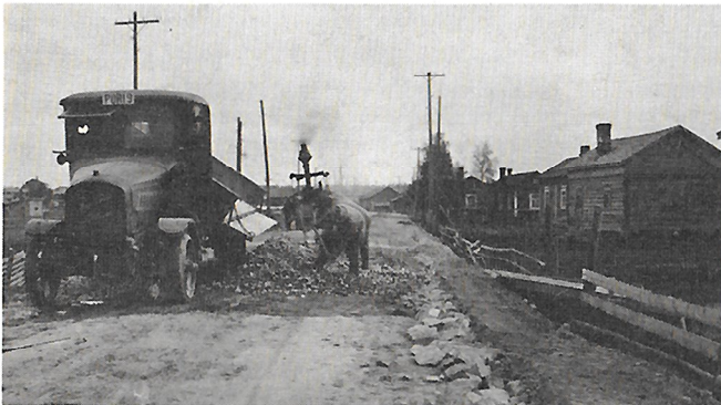
Tienrakentamista höyryjyrän ja kovakumirenkaisen auton voimin jossakin Porin seudulla mahdollisesti 1920-luvulla. Autossa rekisterinumero PORI 9.
